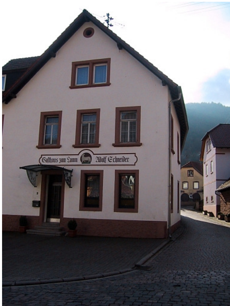
Bild 3: Weitgehende symmetrische Aufteilung der Fassade. Fenster weisen aufrechte rechteckige Formate auf und sind vorzugsweise durch Sprossen gegliedert. Werbung in Form von aufgemalten Schriften, Vordächer ordnen sich der Fassadengliederung unter.
