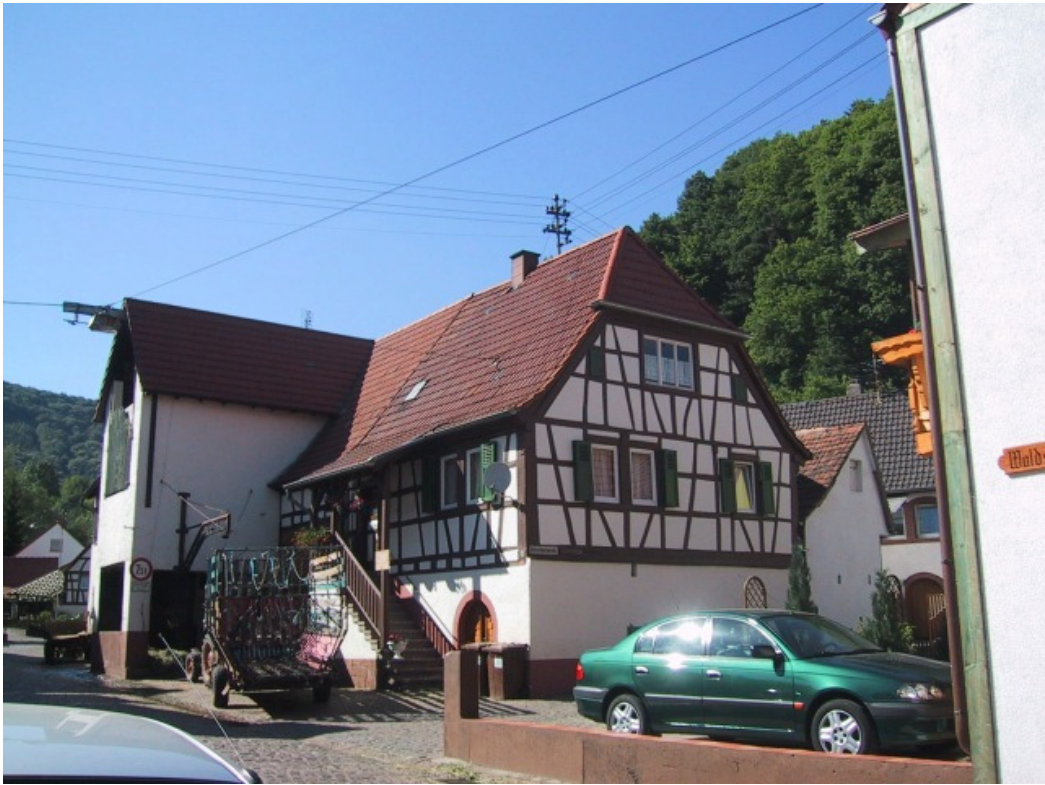
Bild 7: ...Gestaltung von Hof-, Lager-, Abstellflächen im Einklang mit dem historischen Straßen- und Ortsbild
