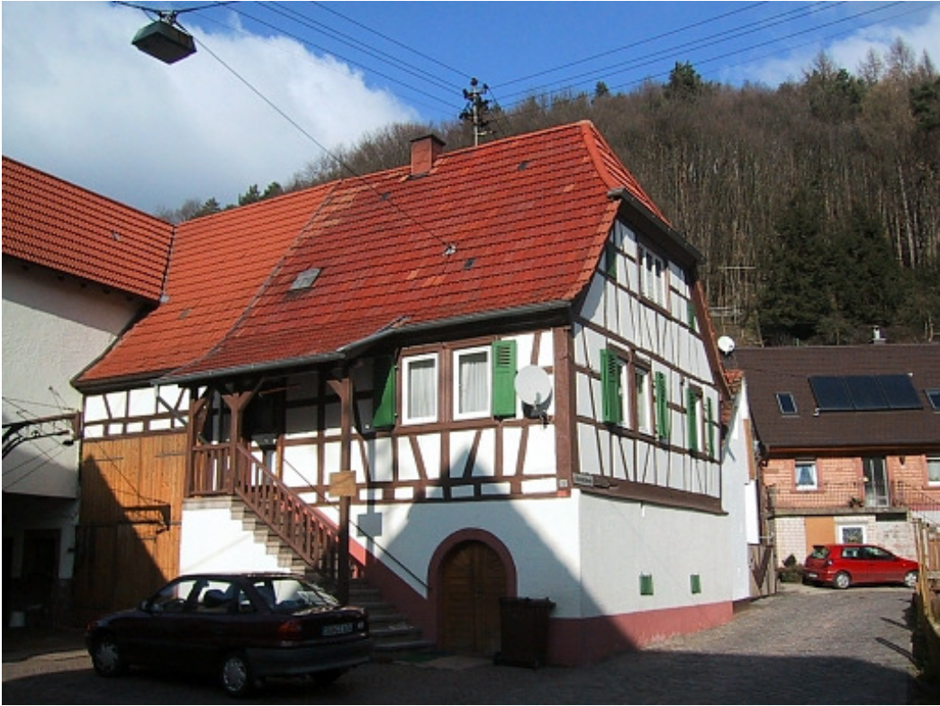
Bild 4: Bei Fachwerkgebäuden sind Fensteröffnungen auf die ursprünglichen Pfostenabstände abgestimmt.
