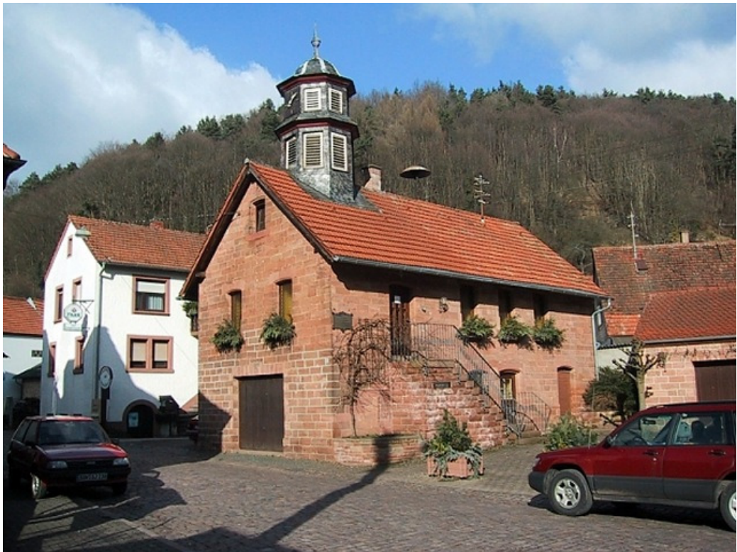
Bild 2: Zulässig sind naturrote bis rotbraune Dacheindeckungen..., an historischen Gebäuden ist auch Schiefer zur Dacheindeckung zulässig.
