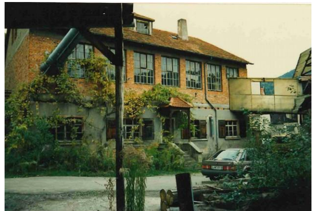
Betriebsgebäude auf Flurst. 317/3
