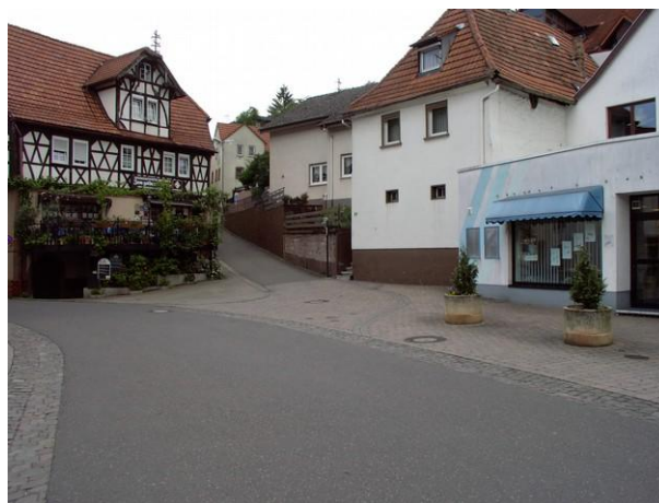
Neugestaltung Kreuzungsbereich Ohlsbachstraße / Mühlstraße / Hauptstraße
