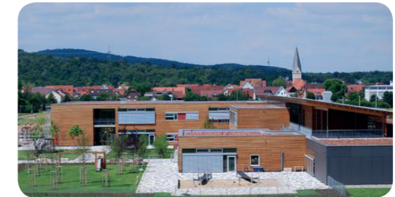
Paradebeispiel für klimaangepasstes, ökologisches Bauen in Schulen: Körper- und Sprachbehinderte Verbundschule in Nürtingen (BW). Bauobjekt beinhaltet Holz als Baumaterial, extensive, wärmedämmende Dachbegrünung, hoher Anteil an Verschattungsflächen, überdachte Dachterrasse, hoher Grünanteil im Außenbereich, Nachtlüftungsklappen für Frischluftaustausch. Quelle: www.zinco-greenroof.com.
