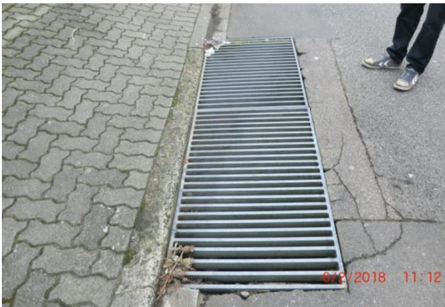
Die abzweigende Schulstraße hat vor Garagen einen Tiefpunkt. In diesem soll ein großes Ablaufbauwerk dafür sorgen, dass hier zufließendes Wasser abfließen kann. Der Ablauf erfolgt vermutlich direkt in die Hahnenbachverrohrung.
