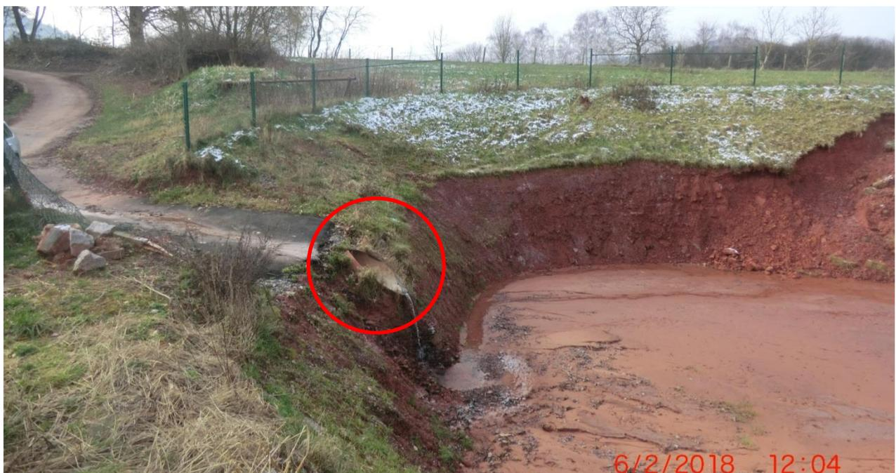
Bei extremen Starkregen kann die Erschließungsstraße das von den bergseitigen Äckern zufließende Oberflächenwasser nicht vollständig nach Norden zum RRB umleiten. Es kommt an mehreren Stellen zu einem wilden Abfluss über die Straße hinweg in die talseitig angrenzenden Ackerflächen im Einzugsgebiet des Klingelbachs (s. Abschnitt 5.5).
