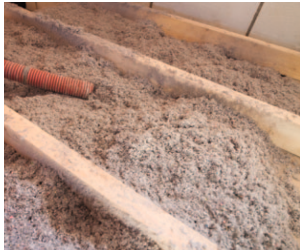
Anwendung von Zelluloseflocken im Fußbodenbereich
