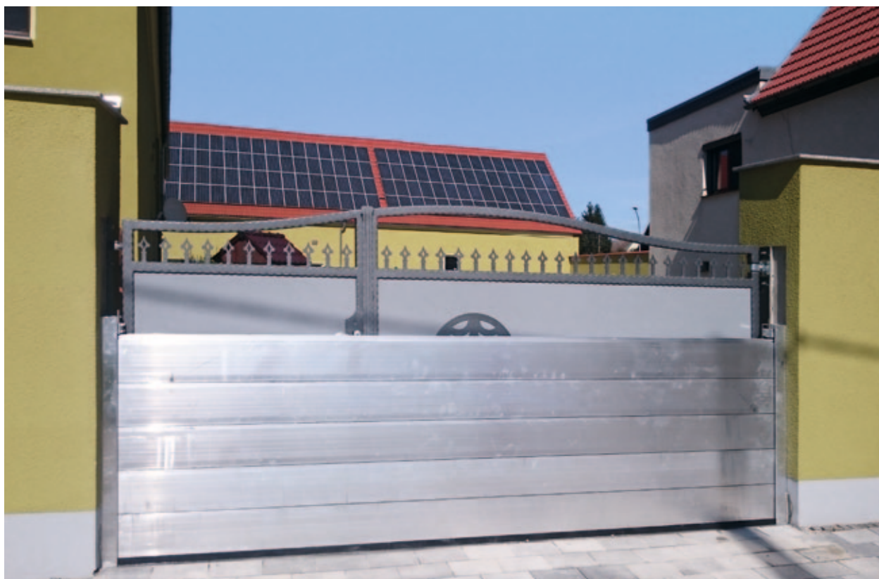
mobiler Hochwasserschutz mit Dammbalken
