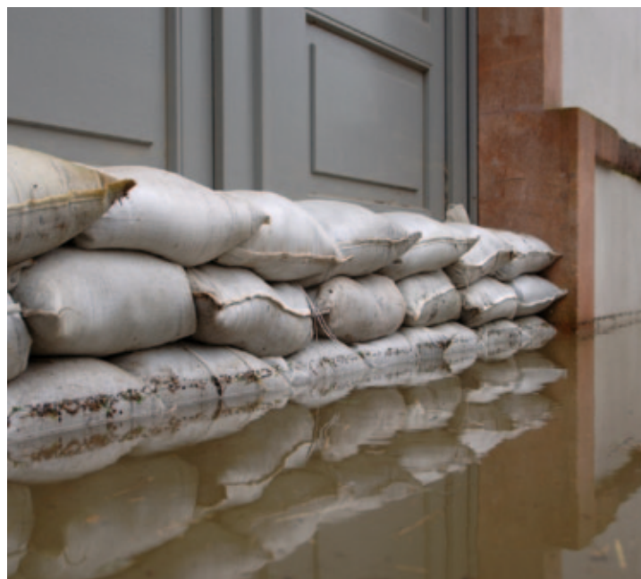
Notfallmäßiger Objektschutz mit Sandsäcken
