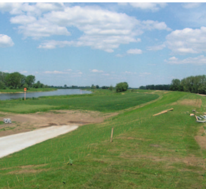
Sanierter Hochwasserschutzdeich an der Elbe
