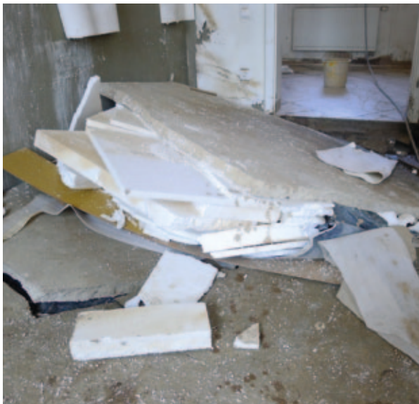
Aufgeschwommene Fußbodenkonstruktion
