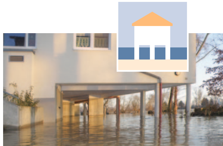
Ausweichen: zum Beispiel durch Aufständern von Gebäuden
