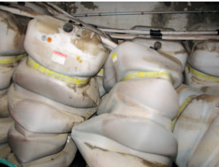
Zerstörte Heizöltanks infolge einer Hochwassereinwirkung
