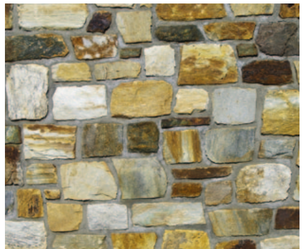
Unregelmäßiges Natursteinmauerwerk
