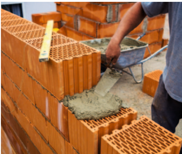
Mauerwerk aus Hochlochziegeln
