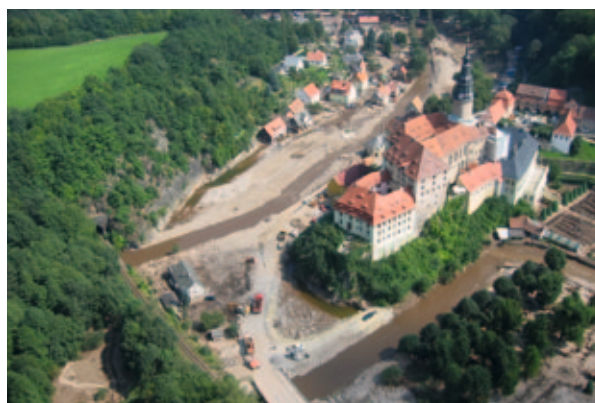
Hochwasserschäden 2002 in Weesenstein an der Müglitz ...
