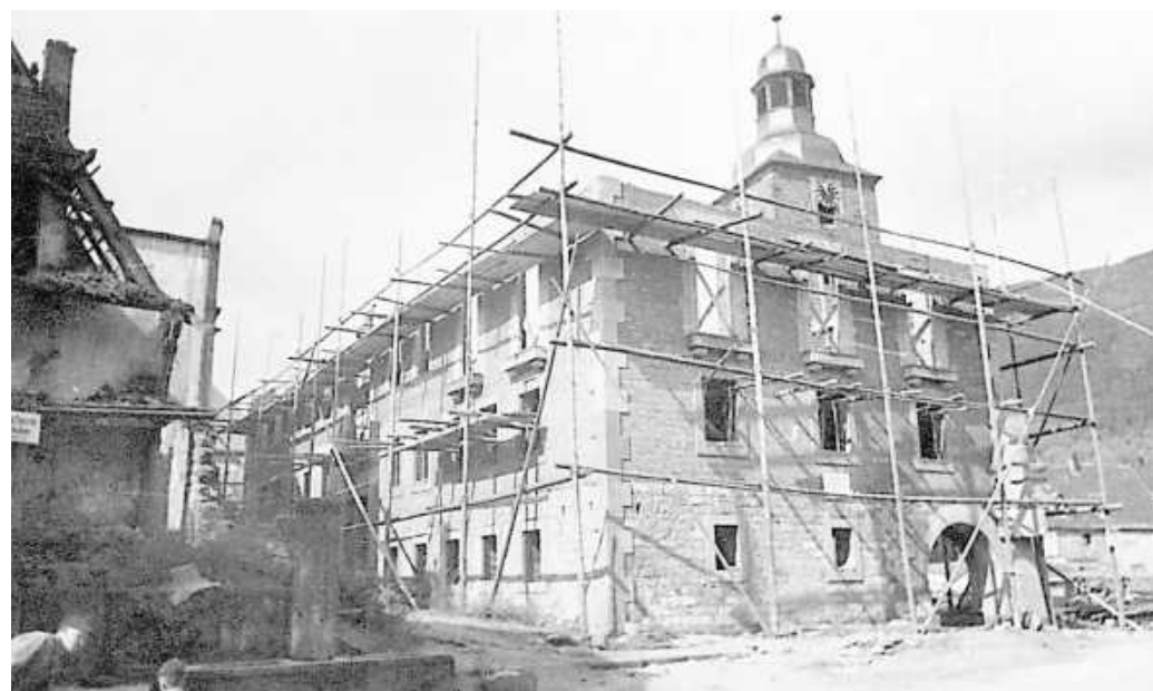
Das neue Rathaus während des Wiederaufbaus
